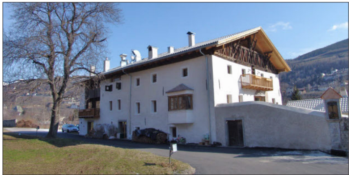
Der Moarhof, vorbildlich saniert.
