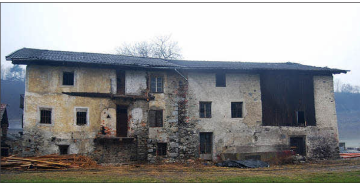
Der alte Moarhof vor der Sanierung.
