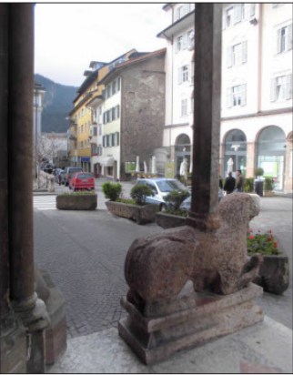
Unverputzte Ecke mit Brunnen am Chiusolehaus.
