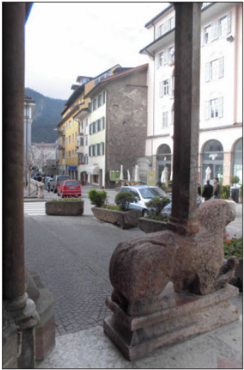
Unverputzte Ecke mit Brunnen am Chiusolehaus.
