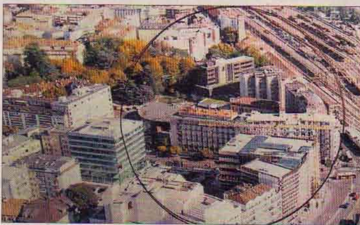
Luftbild vom Bahnhofsbereich
