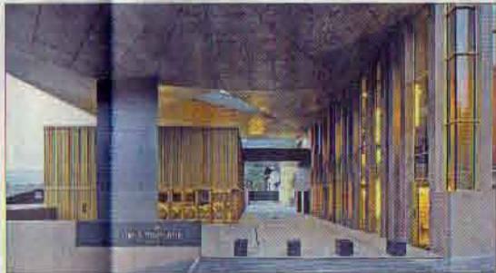
GEWERBE: Architekt Markus Scherer, Kellerei Nals Margreid
