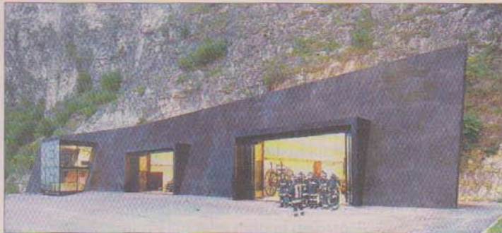
Feuerwehr Margreid, BergmeisterWolf Architekten.
