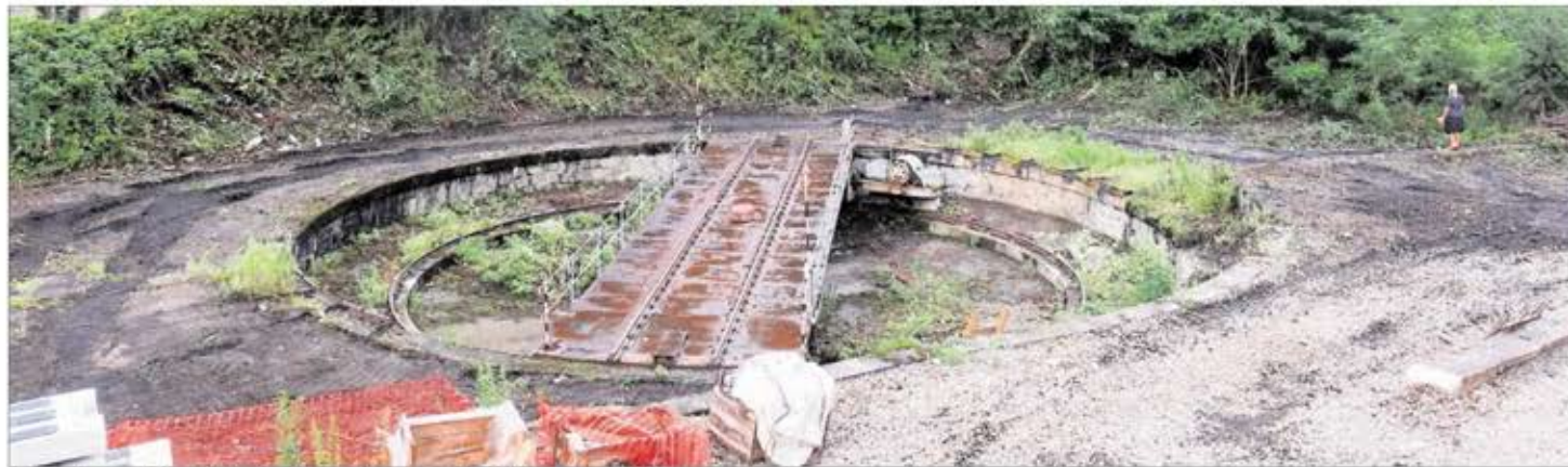
Die verlegte historische Lokomotiven-Drehscheibe von 1874.
