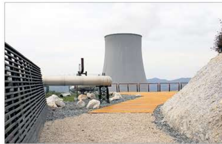
Elektrokraftwerk Sasso Pisano
