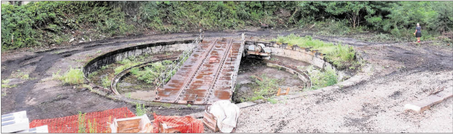
Die verlegte historische Lokomotiven-Drehscheibe von 1874.
