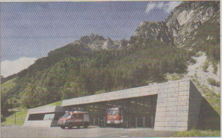
Gelungene Architektur: Das Feuerwehrgerätehaus in Pflersch. OskarDaRiz
