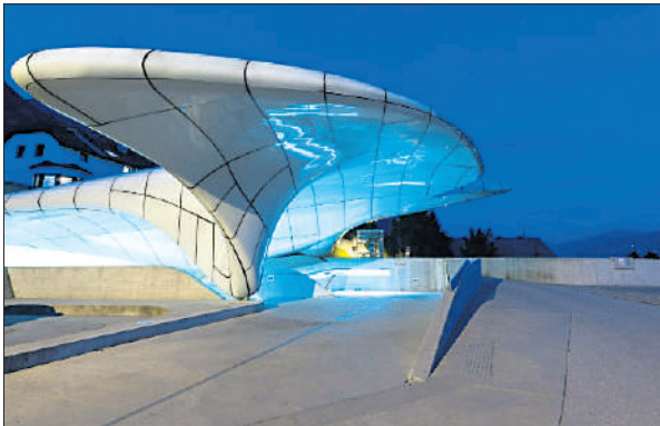
2008: Station Hungerburg der Nordkettenbahn in Innsbruck
