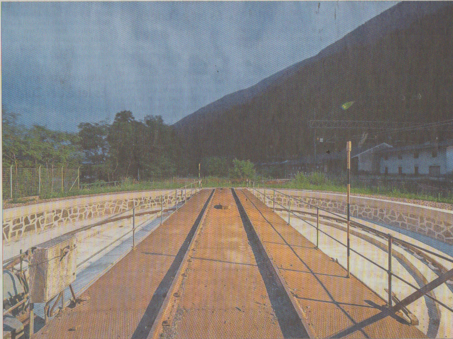
Die Drehscheibe zum Wenden von Dampflokomotiven wurde dort eingesetzt, wo Platzmangel war. Die Lokomotive wird um ihre Achse gedreht, um die Fahrtrichtung zu ändern oder um in ein benachbartes Gleispaar umzusetzen.
