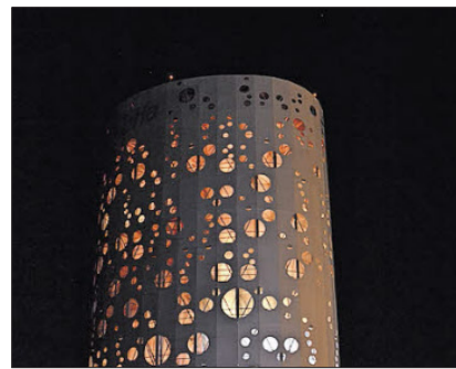
...auf Orange und Rot verändert sich der Turm.
