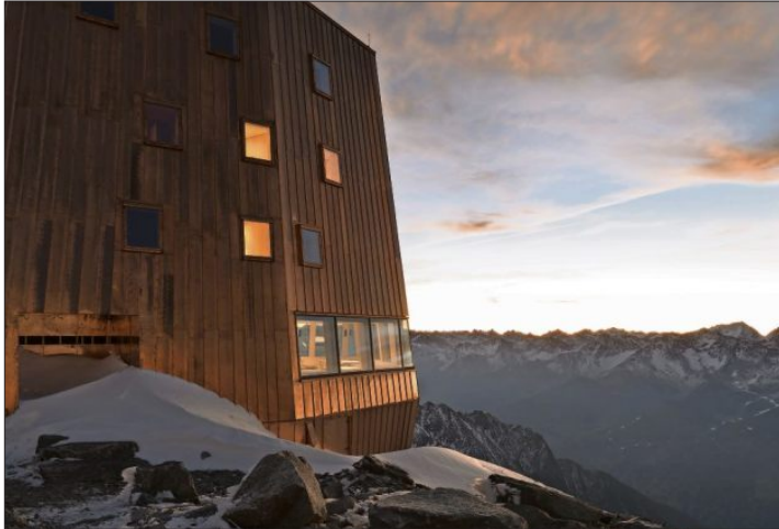
Der Baukörper wurde in eine Stehfalzdeckung aus Kupferblech gehüllt.
